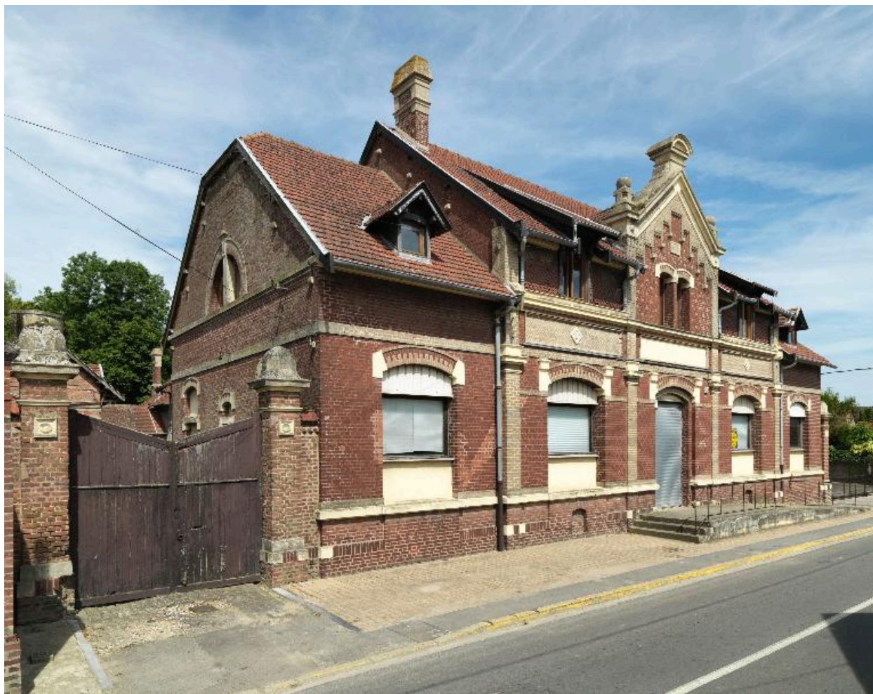
Vue d'ensemble de la façade sur rue.
