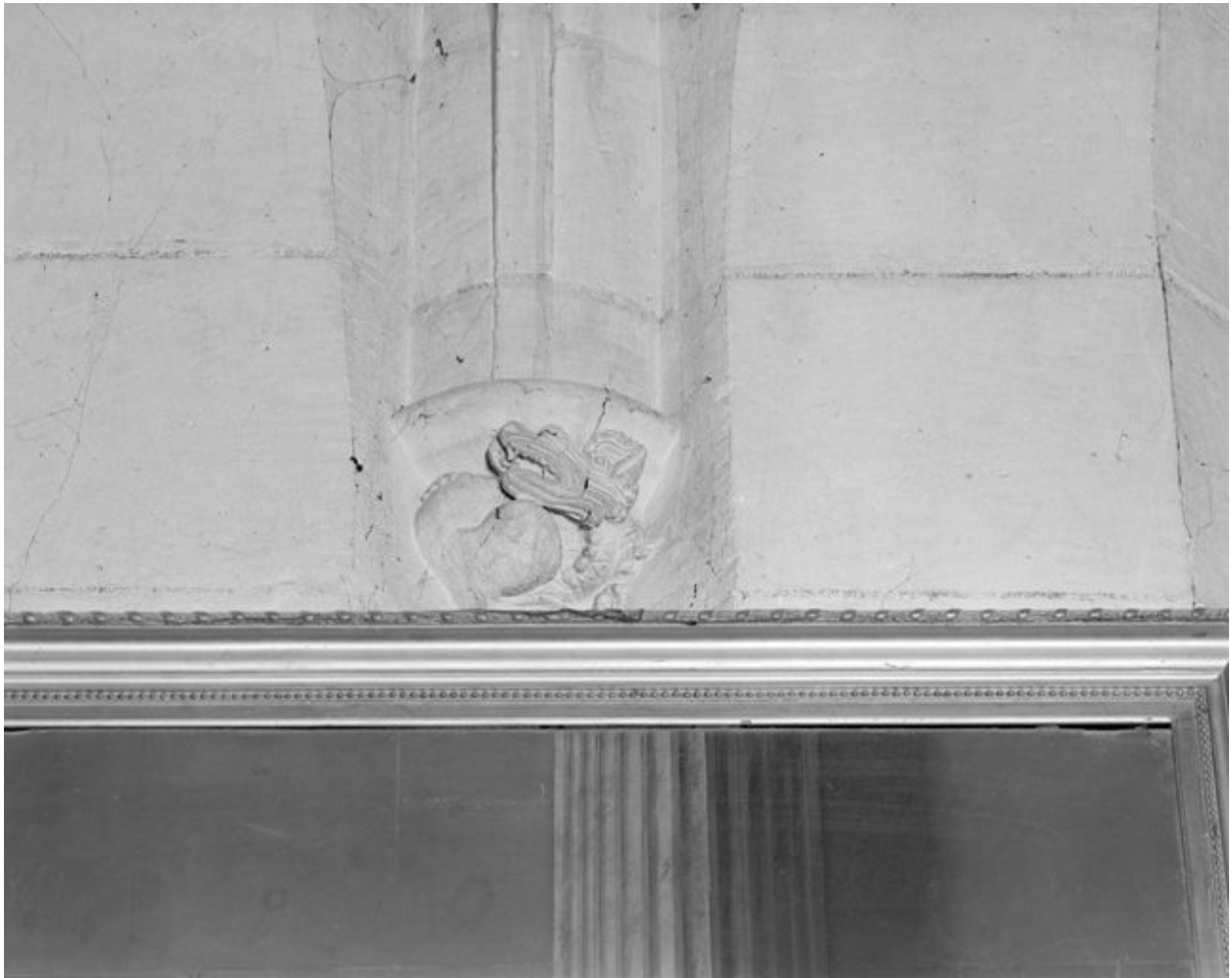
Culot, première travée, angle gauche, 16e siècle.
