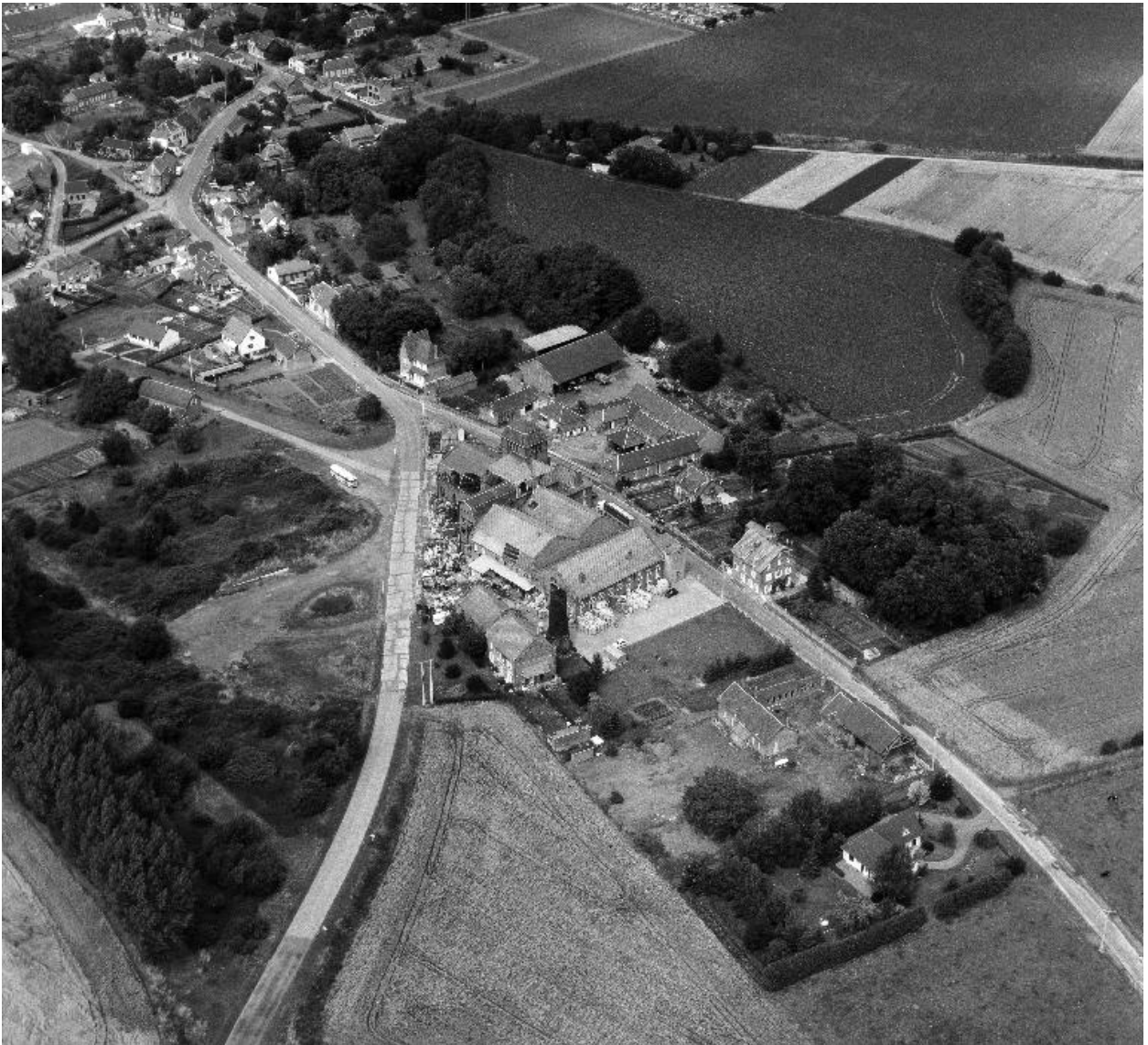
Vue aérienne, flanc sud-ouest.
