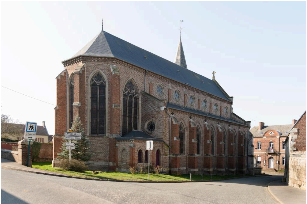
Vue du chevet et de l'élévation nord.
