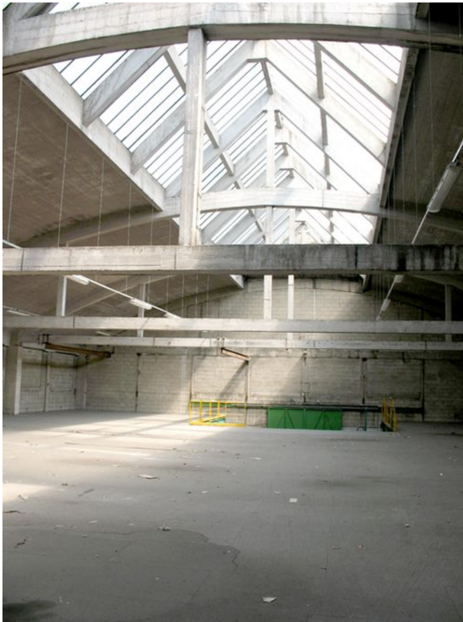
Lanterneau vitré éclairant l'extension de la fonderie.
