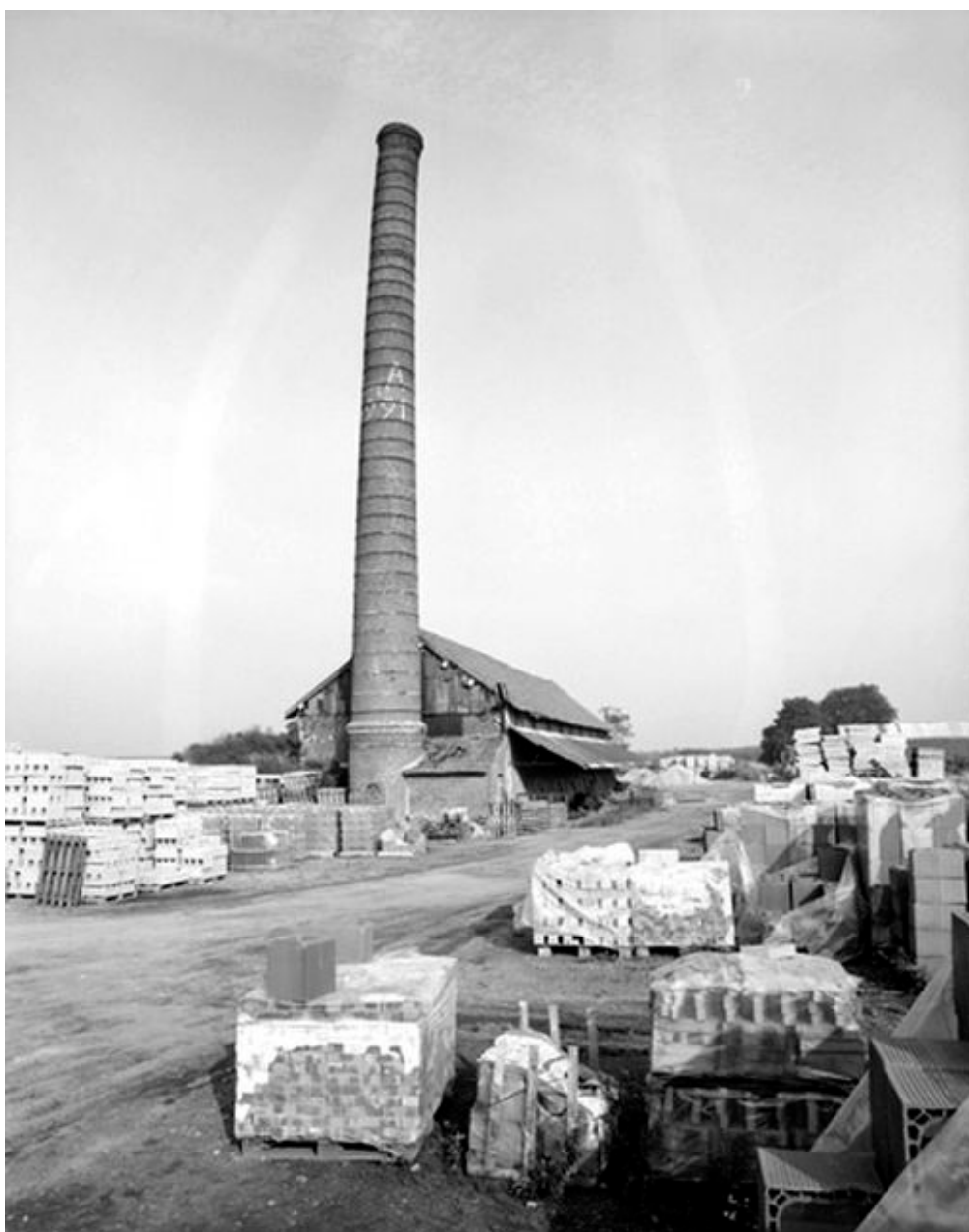
Four industriel et cheminée.
