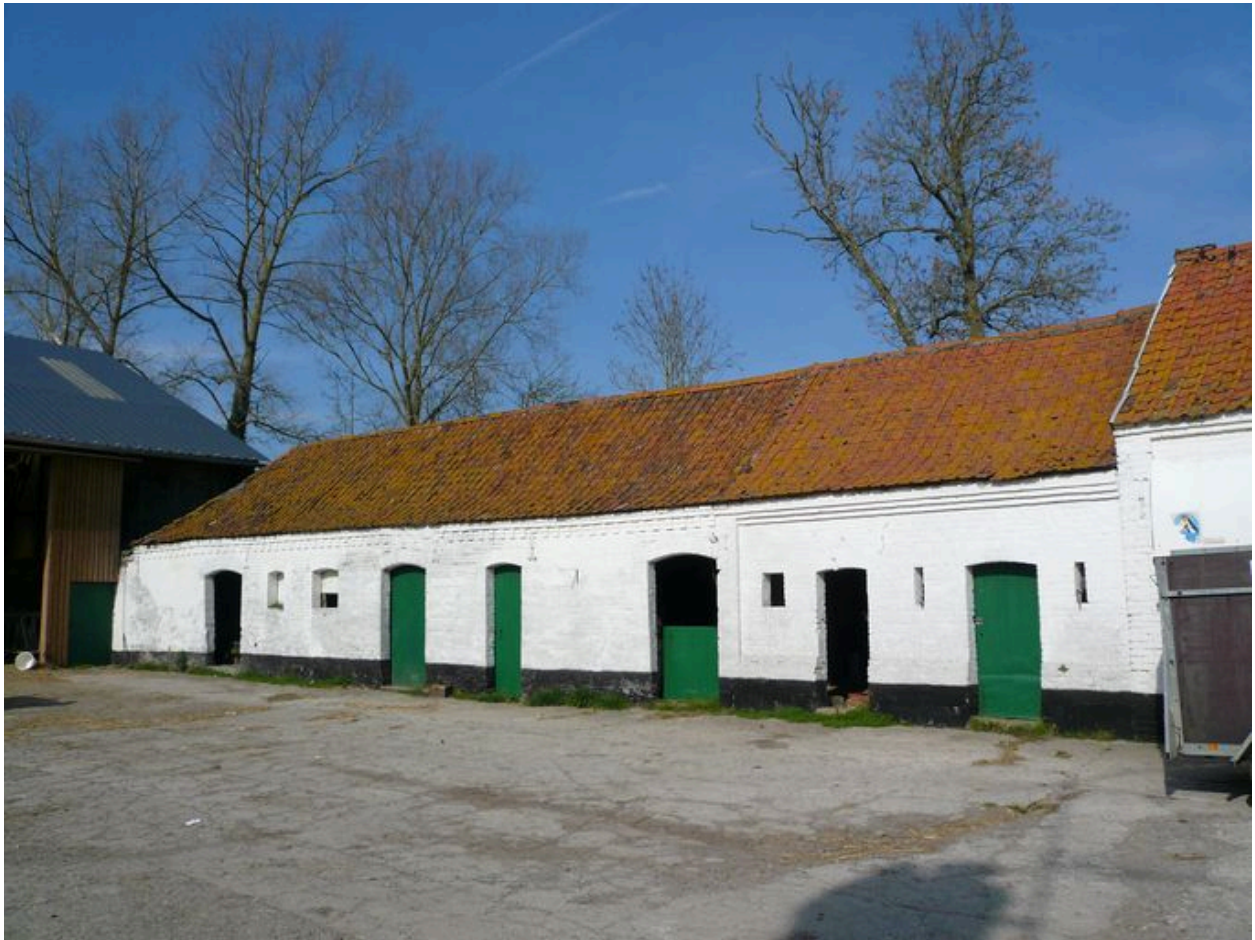
Vue des porcheries dans leur prolongement au nord.
