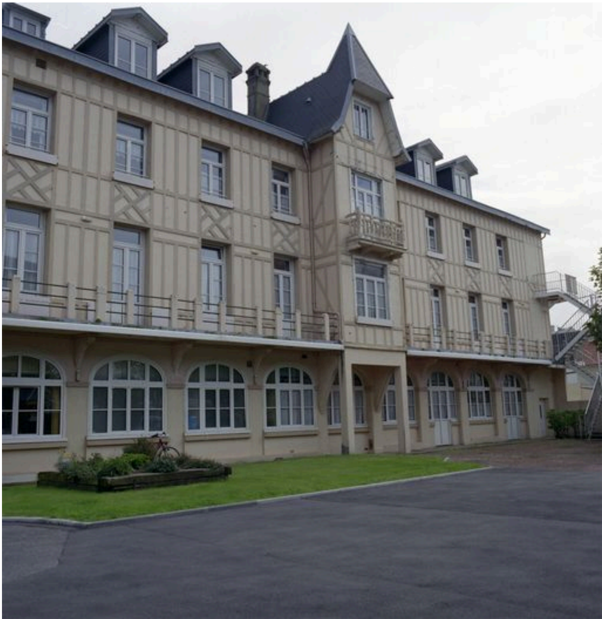
Vue d'ensemble de la façade donnant du côté de la rue Eugène-Trigoulet, vue de trois-quarts gauche.
