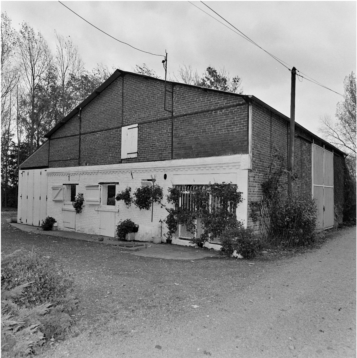
Anciennes écuries transformées.
