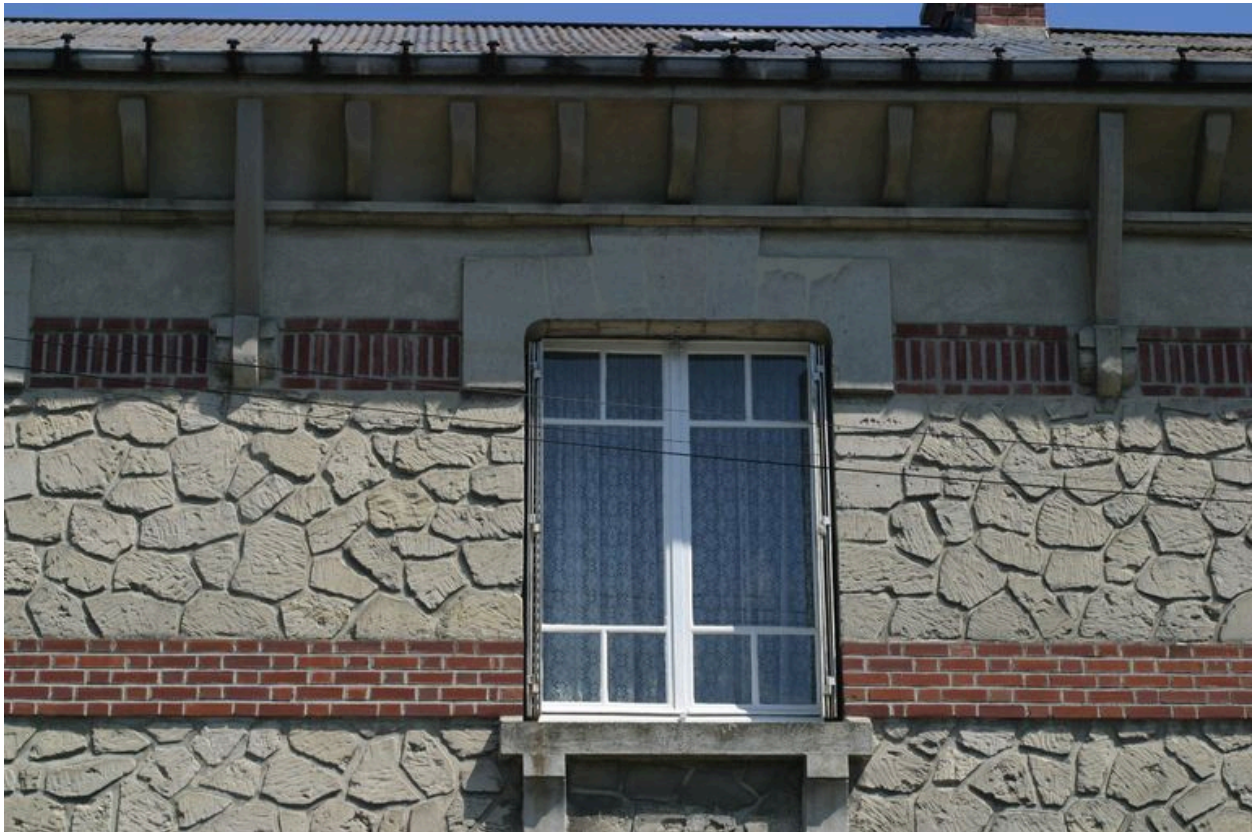
Détail d'une des baies de l'étage.
