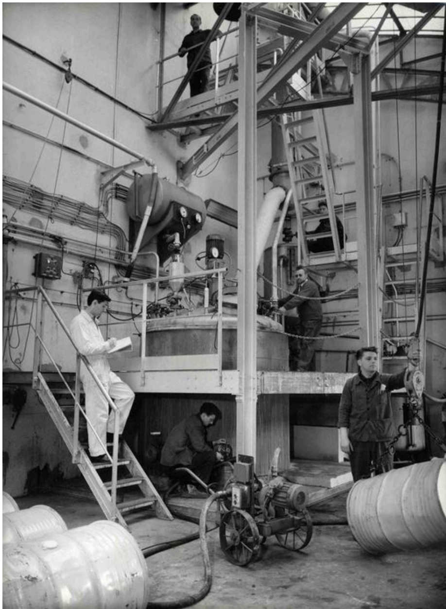
Fabrication des glycérophthaliques par système azéotropique, vers 1950 (archives d'entreprise).
