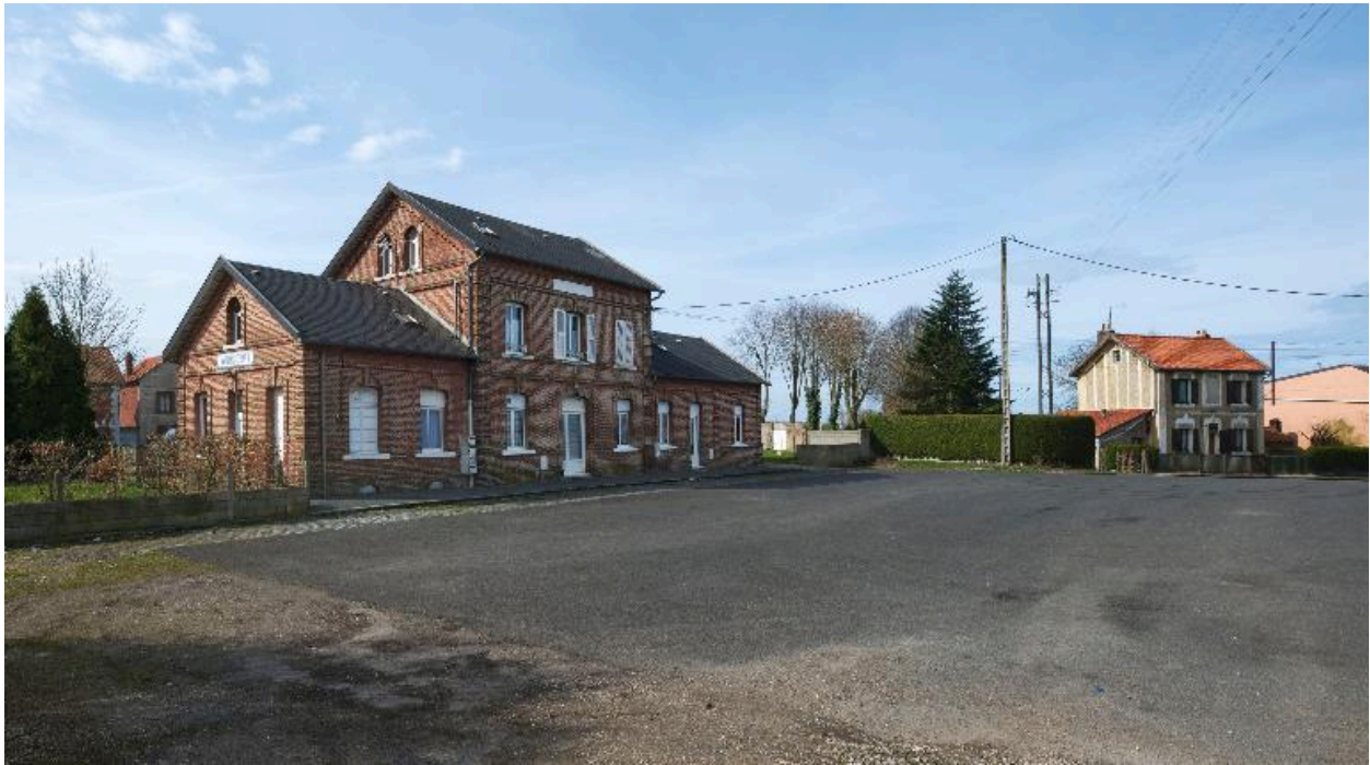
Vue générale depuis la place de la gare.
