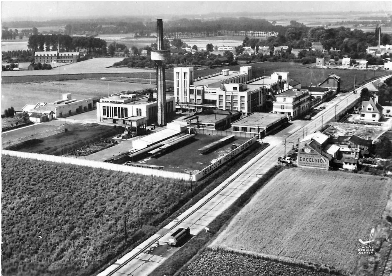
Vue aérienne de l'usine vers 1950. (Coll. part.)
