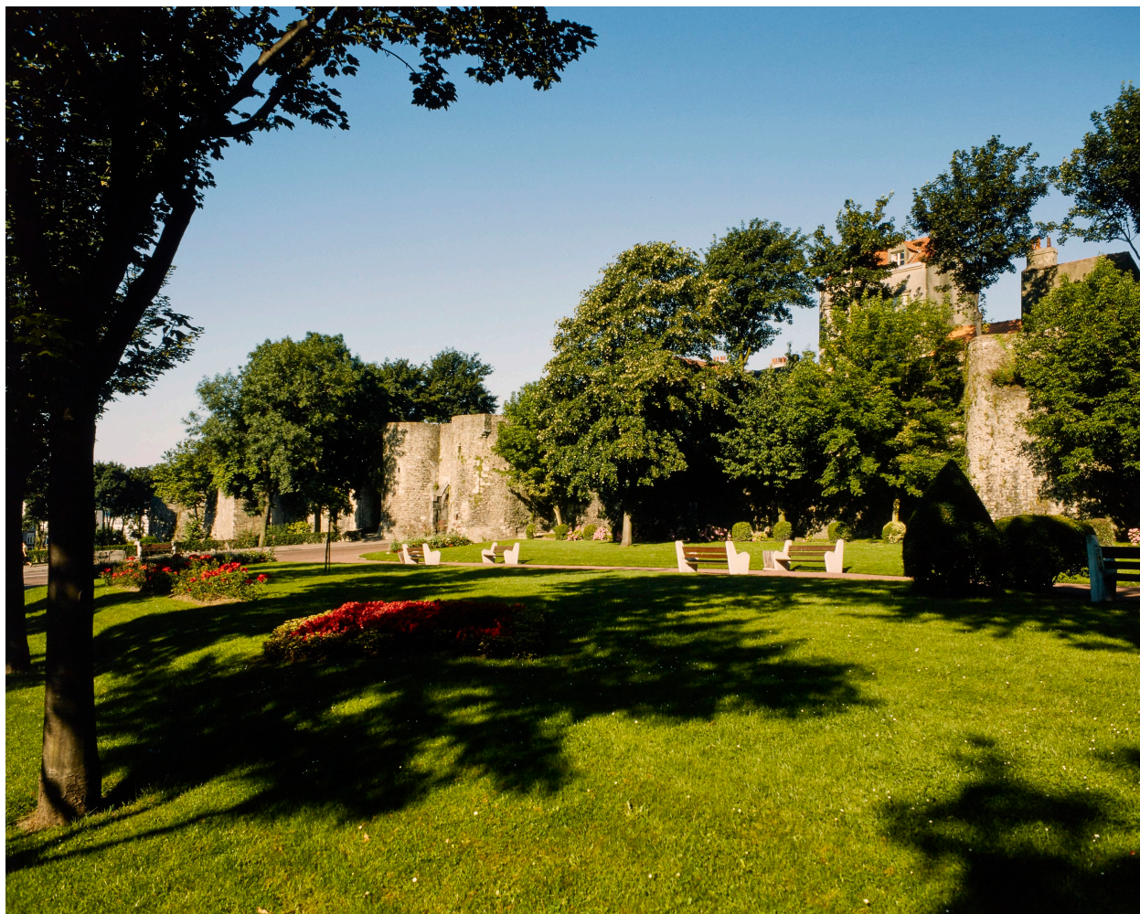
Vue sur boulevard, vue générale sud-est.
