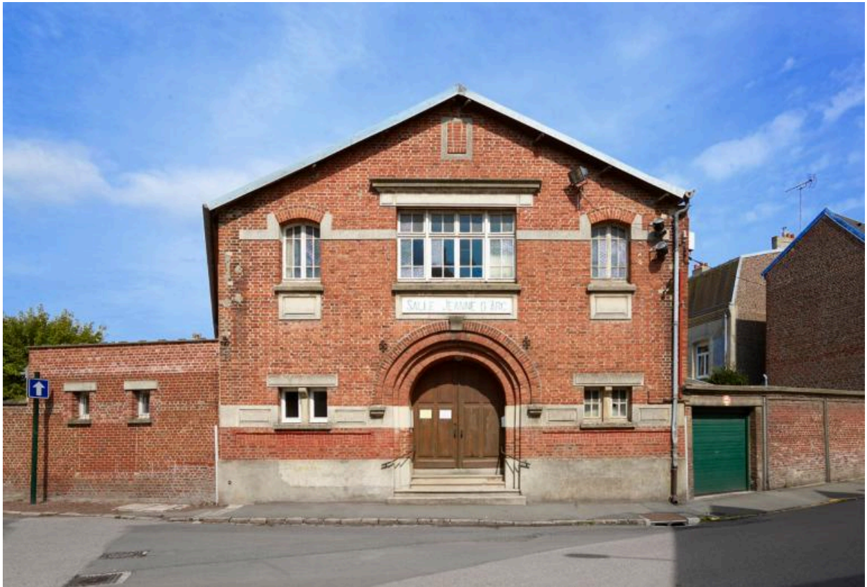
Vue de la façade principale depuis la place de l'église.
