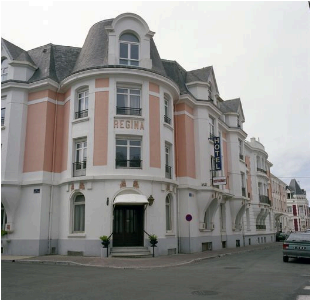
Elévations sur les rues de Lhomel et Eugène-Trigoulet, vue angulaire montrant l'enfilade des façades donnant sur la rue de Lhomel.
