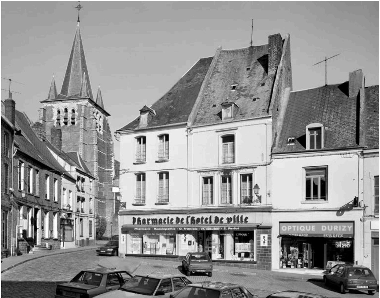
Vue de la façade sur rue.
