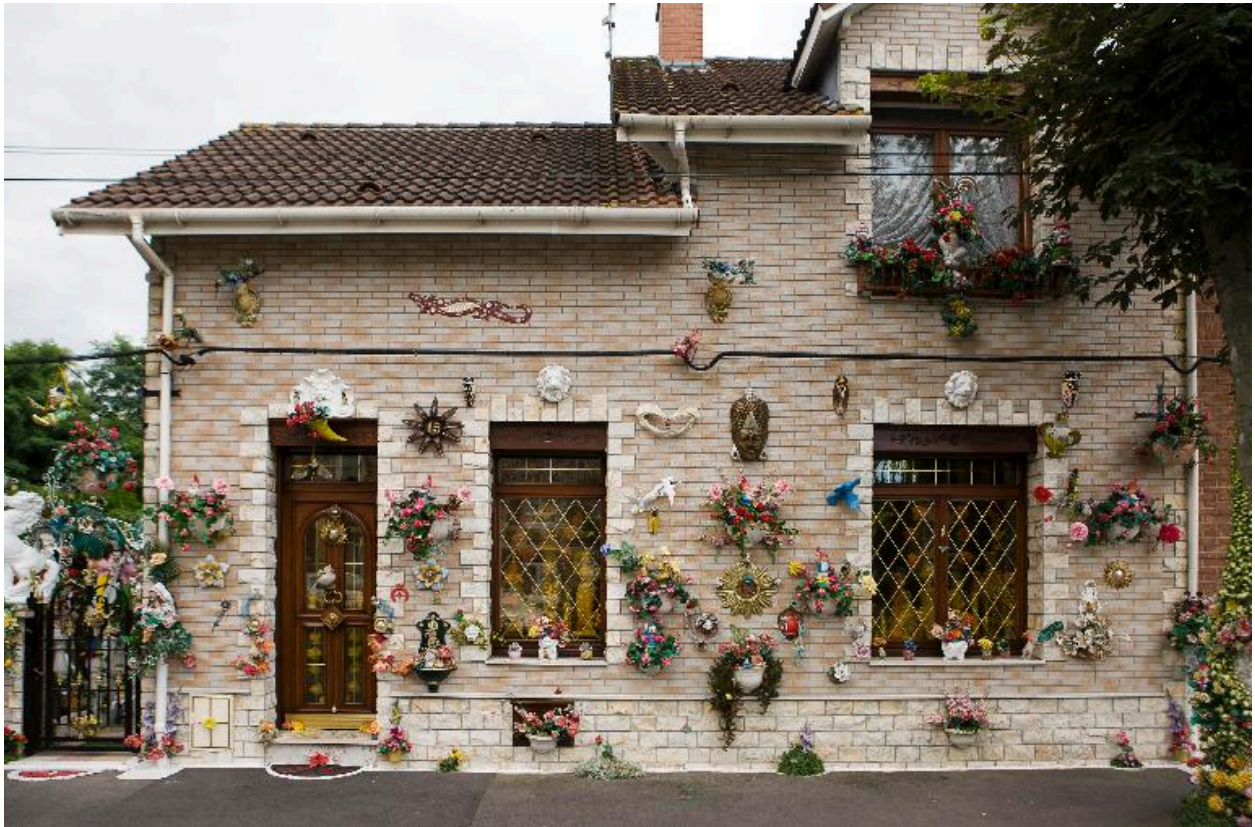
Vue générale de la façade de la maison.
