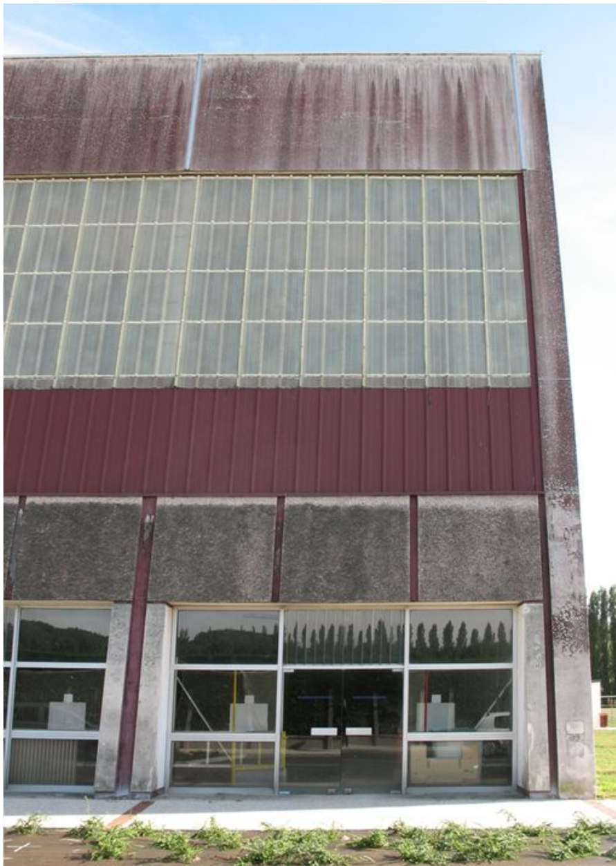
Détail d'une travée de la façade nord.
