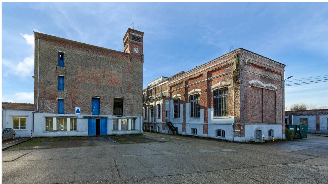
Vue d'ensemble des anciens ateliers de fabrication de la filature et de l'ancienne chaufferie (bâtiment A et K).
