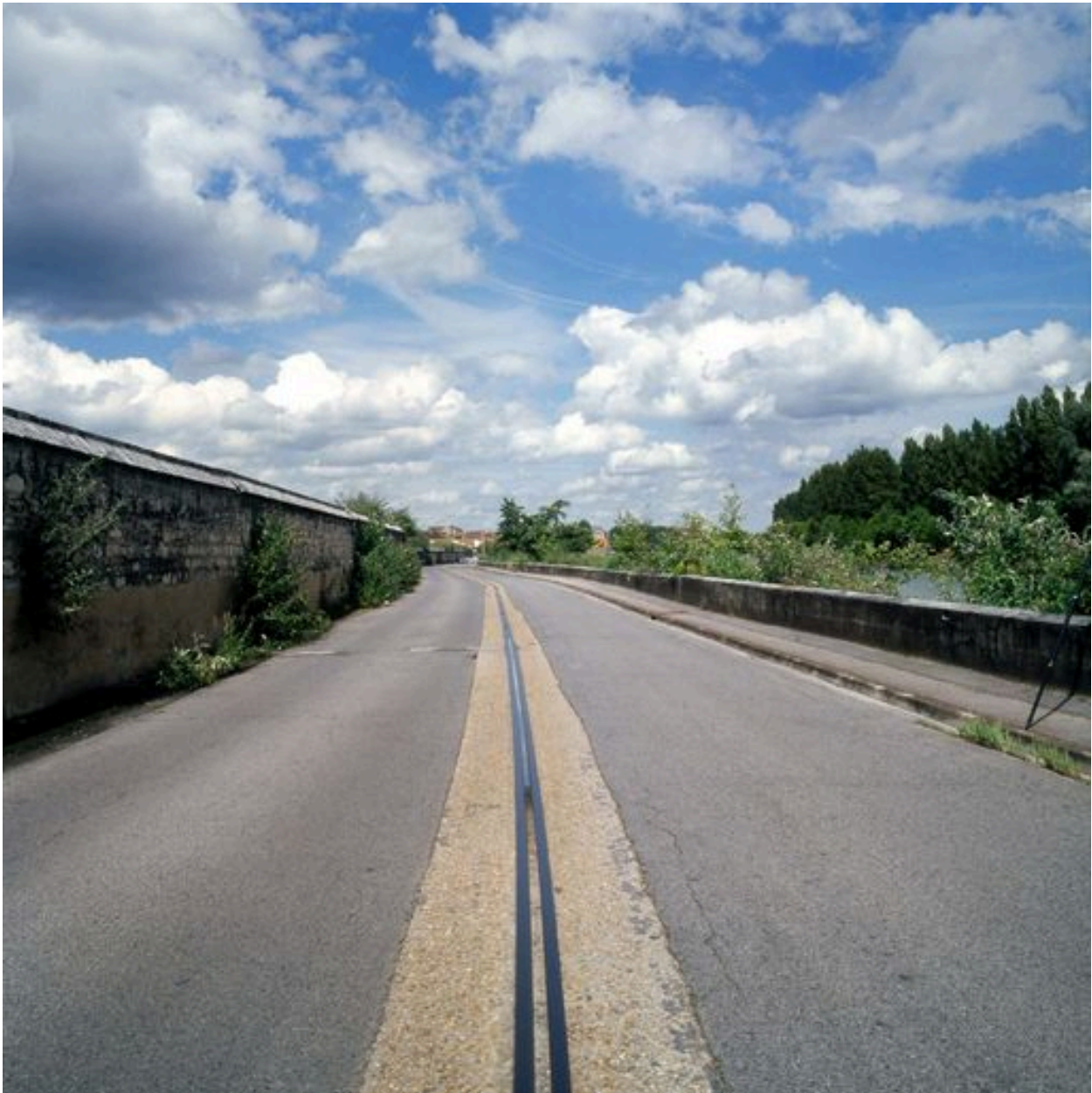
Rails de la grue utilisée par l'usine de la Vieille-Montagne sur le quai d'Aval.
