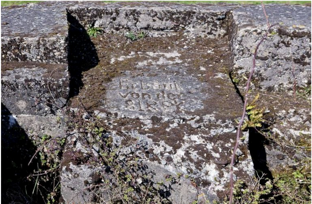
Bâtiment A : Position de la mitrailleuse. Dispositif de blocage de l'affût
