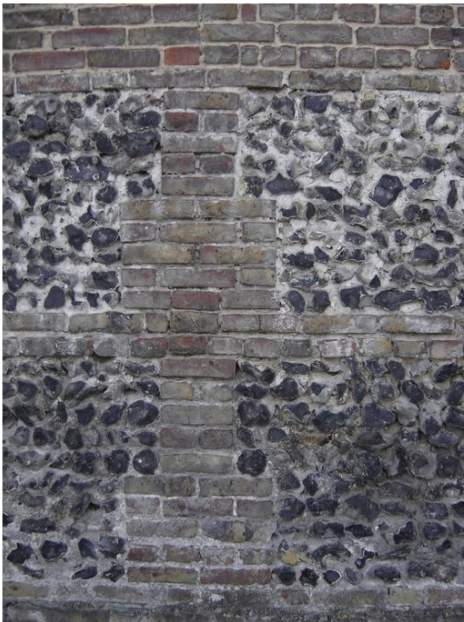
Vue détaillée d'un appareillage mixte de brique et silex.
