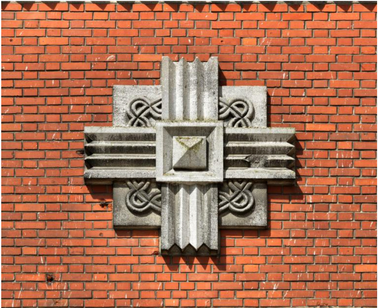
Vue de détail sur le décor moulé en ciment.
