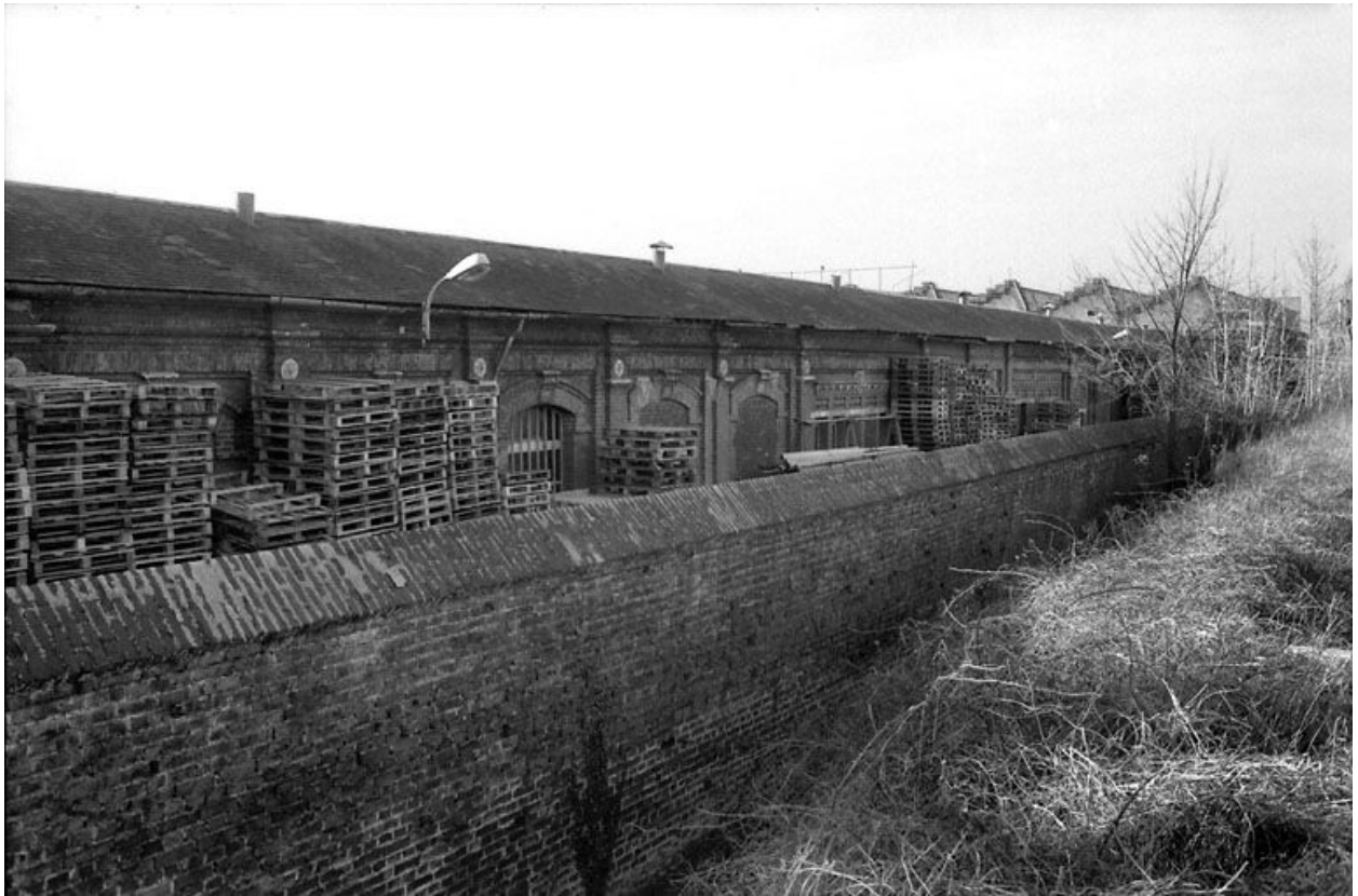
Atelier de fabrication (1), flanc est.
