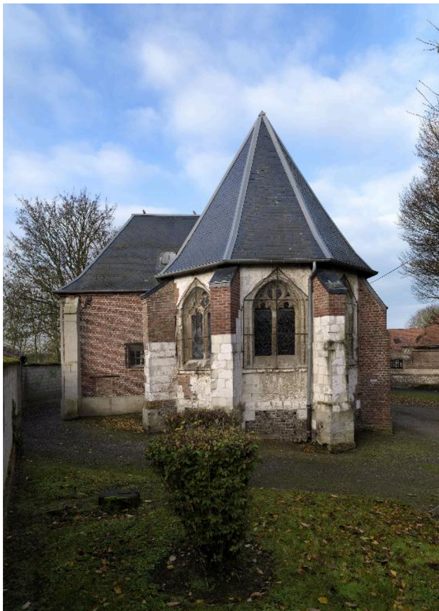
Vue extérieure du choeur et de la sacristie.
