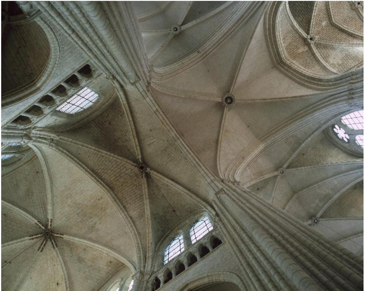
Vue de la voûte du bras sud et de la croisée du transept.
