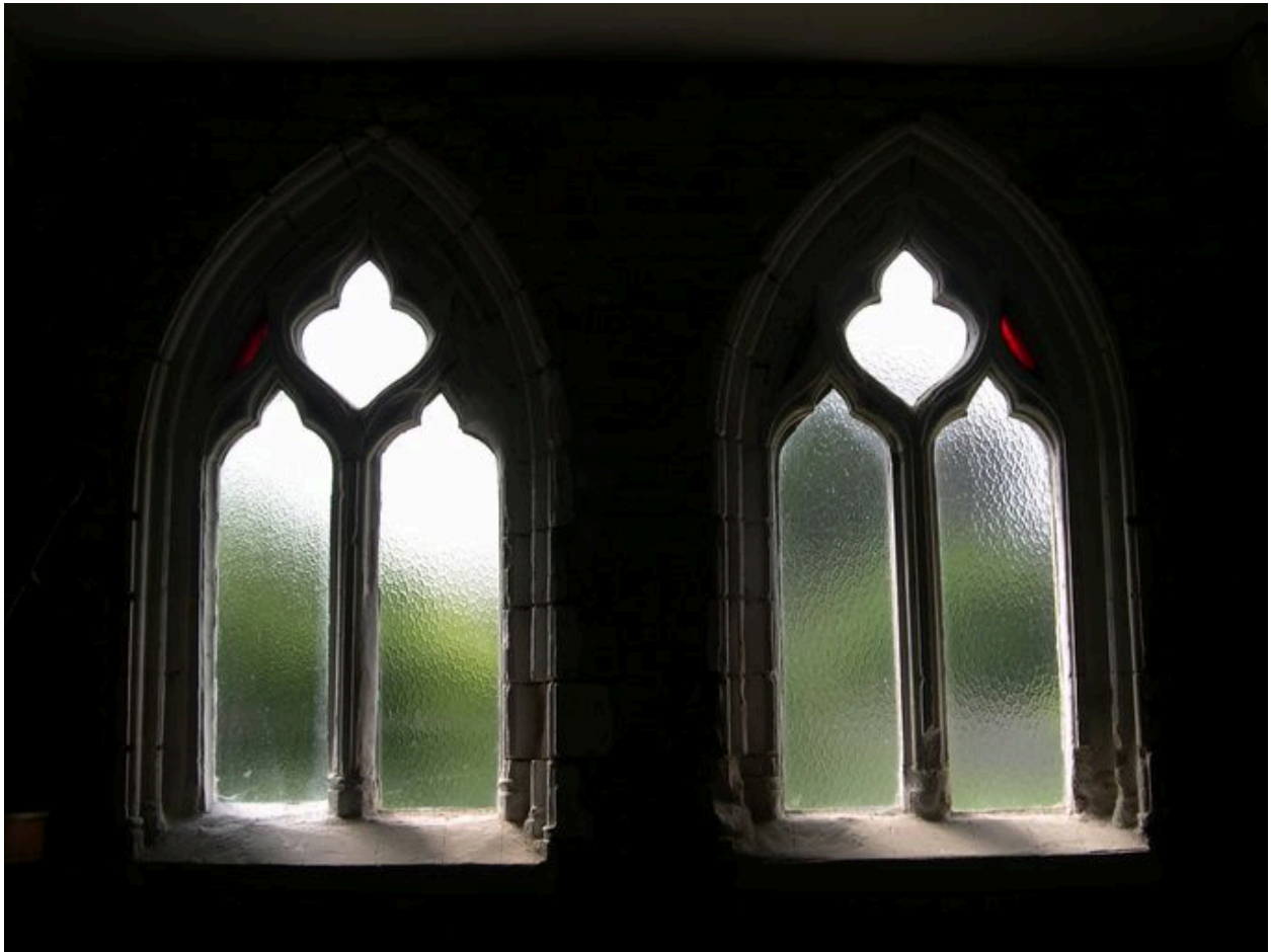
Baies en remploi dans la sacristie (mur sud).
