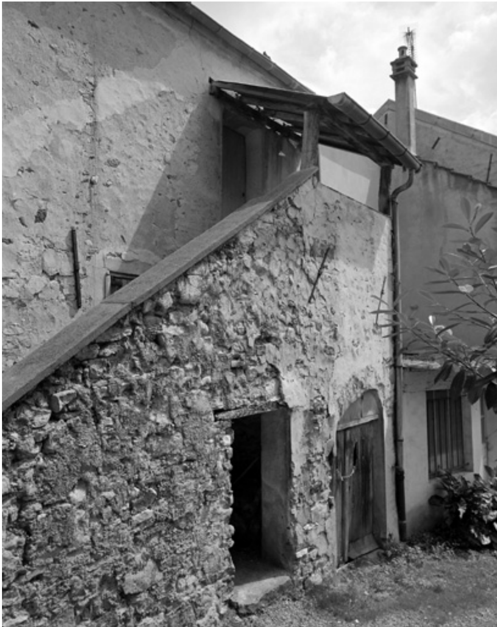
Vue de l'escalier extérieur du côté de la cour.
