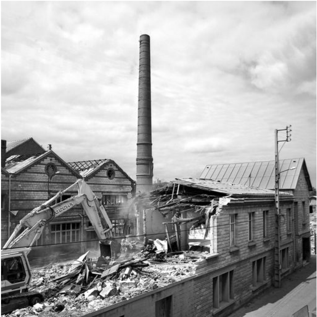
Démolition des bureaux, en 1999.
