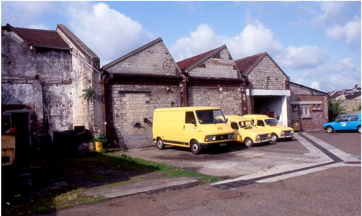
Ateliers couverts en sheds en 1992.
