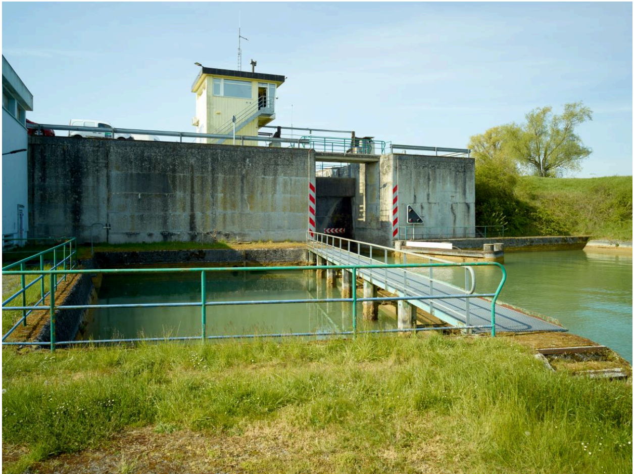
Vue en aval du site. Bassin de tranquillisation, passerelle, poste de commande, porte levante.
