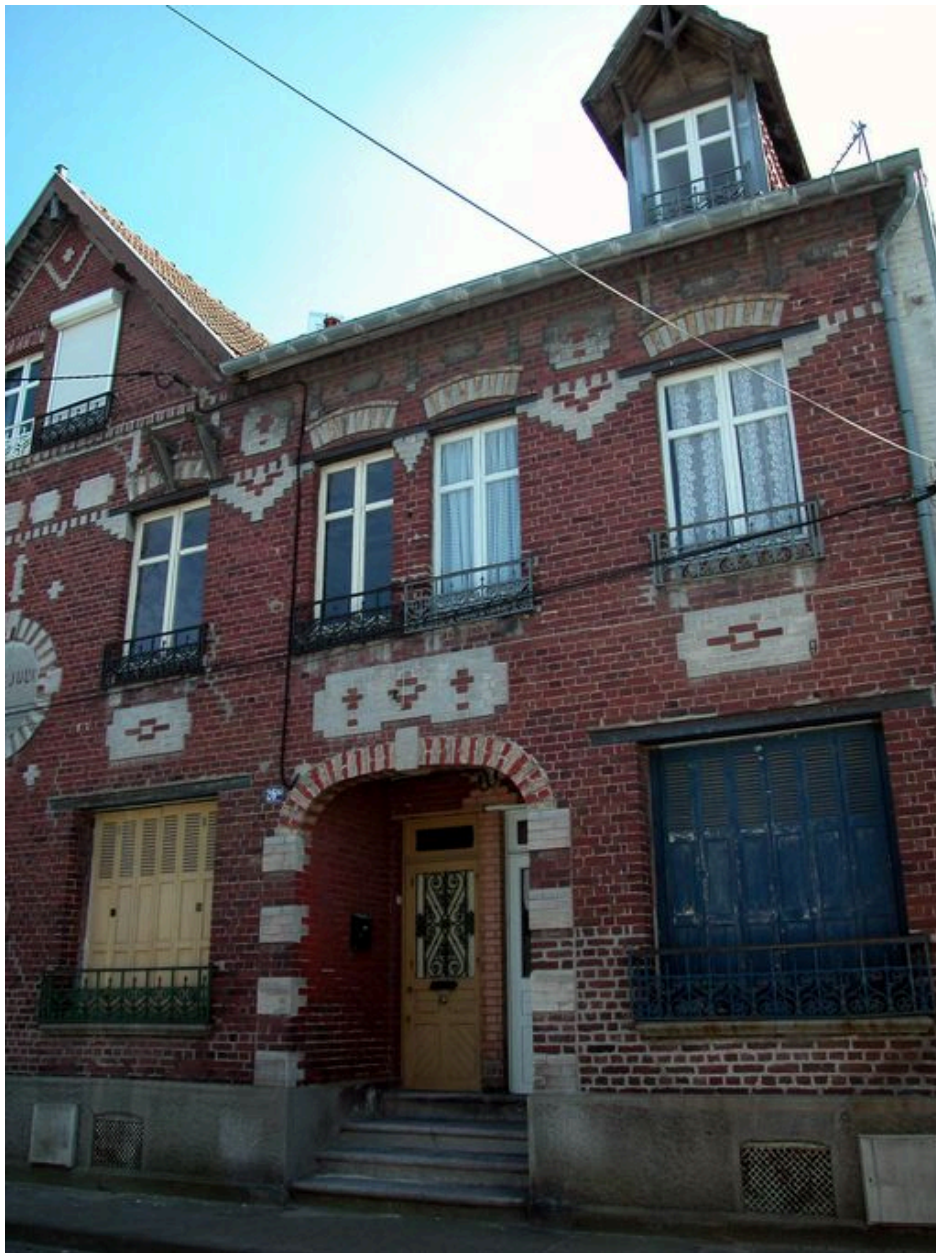
Détail des deux logements de droite.
