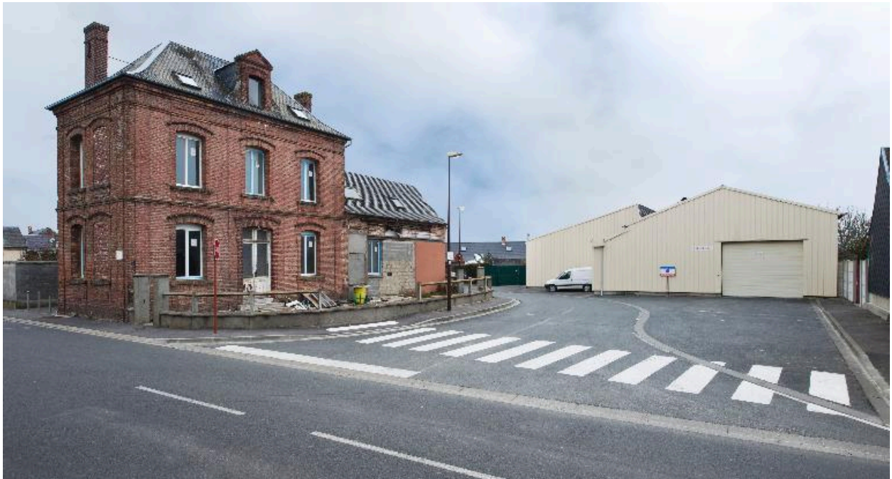
L'ancien logement patronal (vers 1894) et les vestiges des ateliers de fabrication (vers 1891), vus depuis le sud-est.
