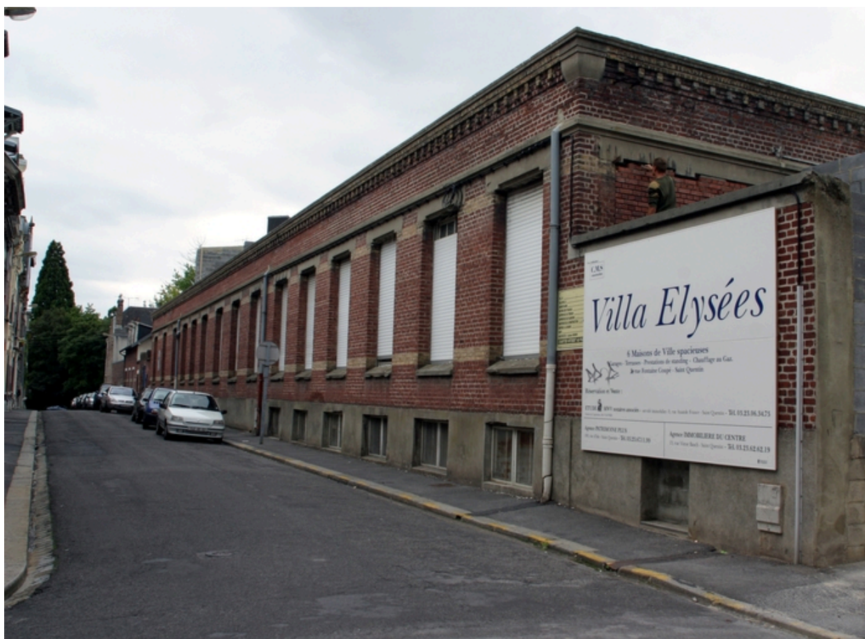
Façade des bureaux bordant la rue Fontaine-Coupé.
