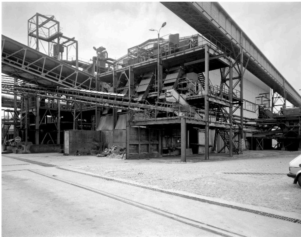
Unité de lavage.
