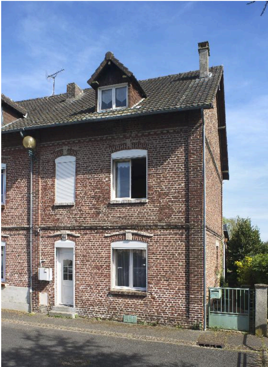
Façade sur rue d'un logement (2 place de la Raffinerie).
