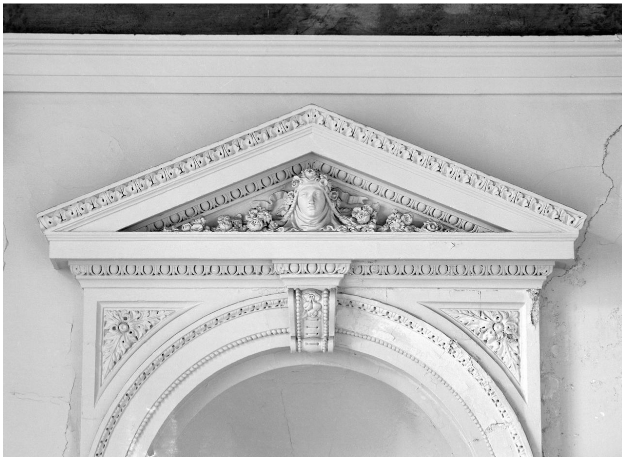
Fronton de la niche de l' escalier.
