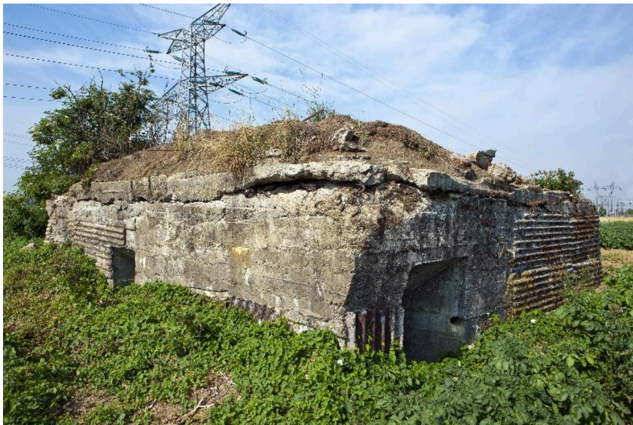
Vue de trois-quarts vers l'ouest
