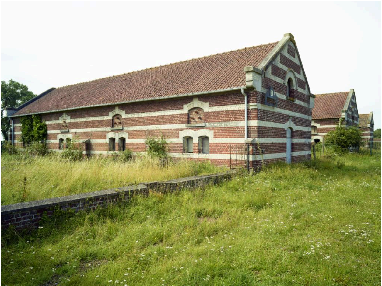
Vue nord-est des anciennes porcheries.
