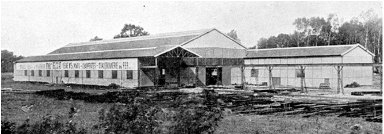
Vue générale de l'usine après sa reconstruction (Le Monde Illustré, 25 octobre 1921).
