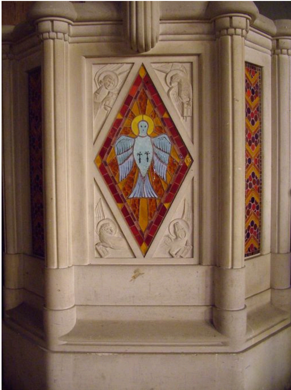
Détail de l'ambon nord.
