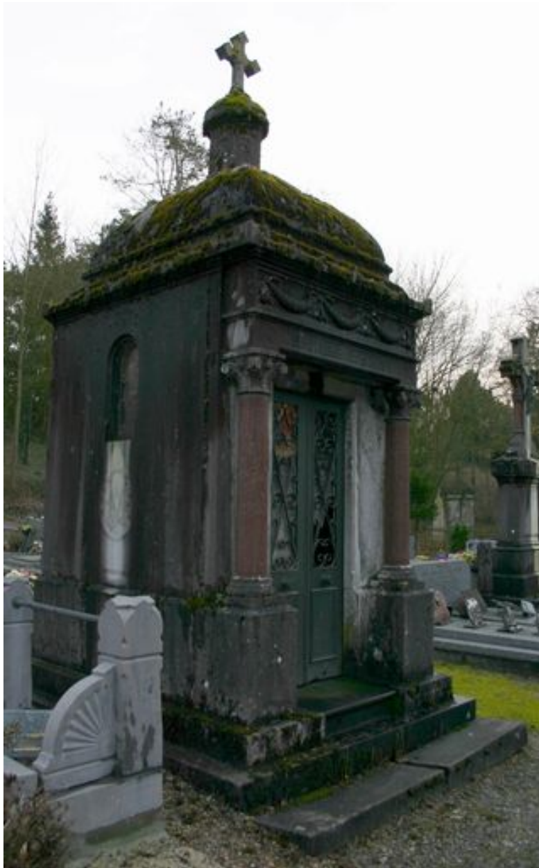
Vue générale du tombeau-chapelle, depuis le côté.
