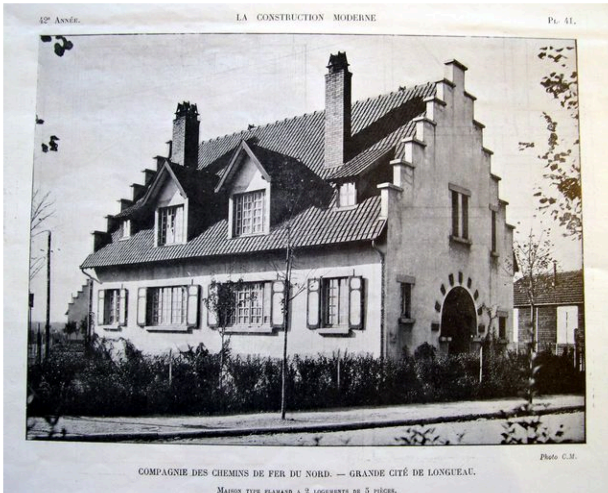
Maison de type flamand. La construction Moderne, n° 11, 12 décembre 1926.
