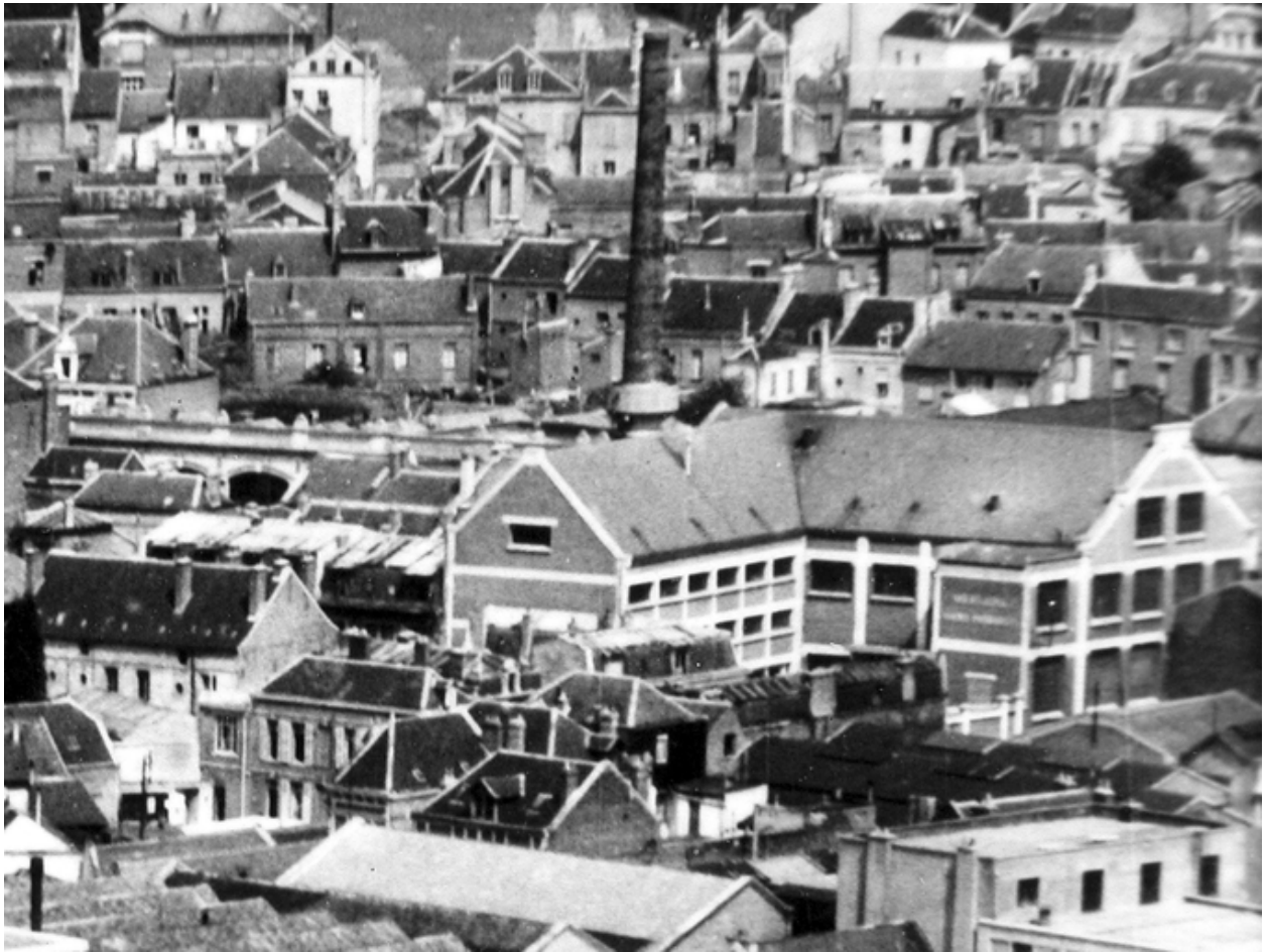
Vue aérienne du site vers 1950-1960 (AD Aisne).
