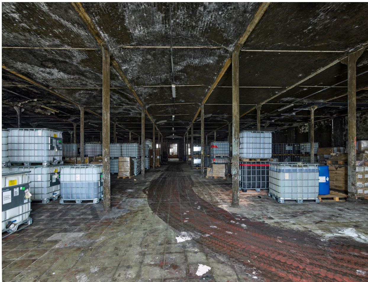
Intérieur du rez-de-chaussée de l'atelier de fabrication.
