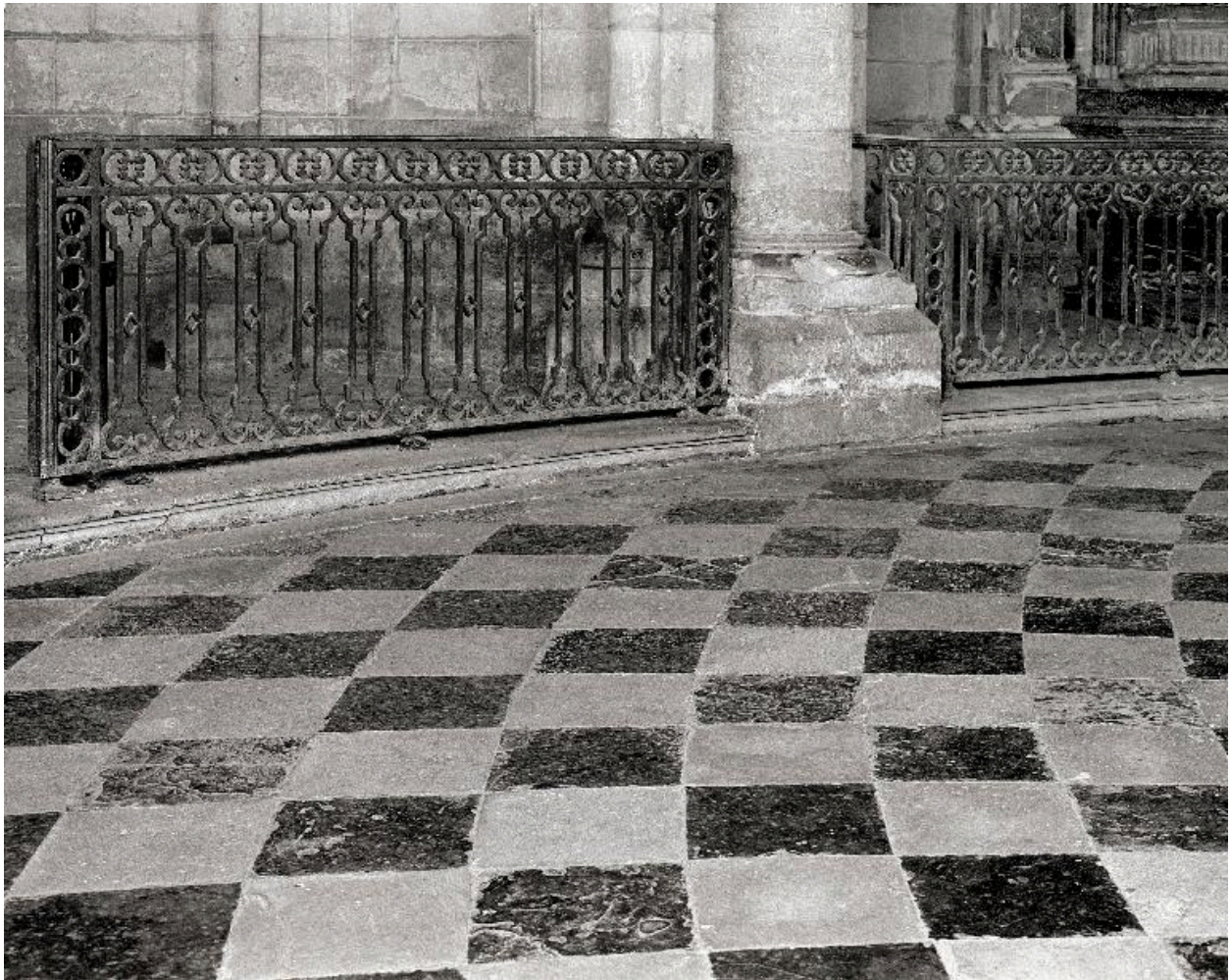
Détail du carrelage de sol du déambulatoire.
