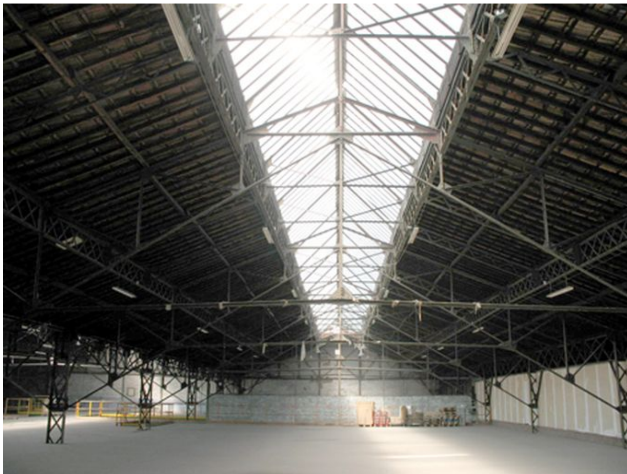
Charpente métallique des ateliers de montage.
