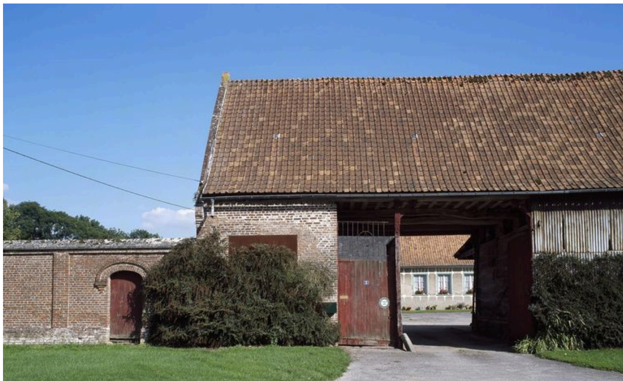
Porte et passage charretiers.
