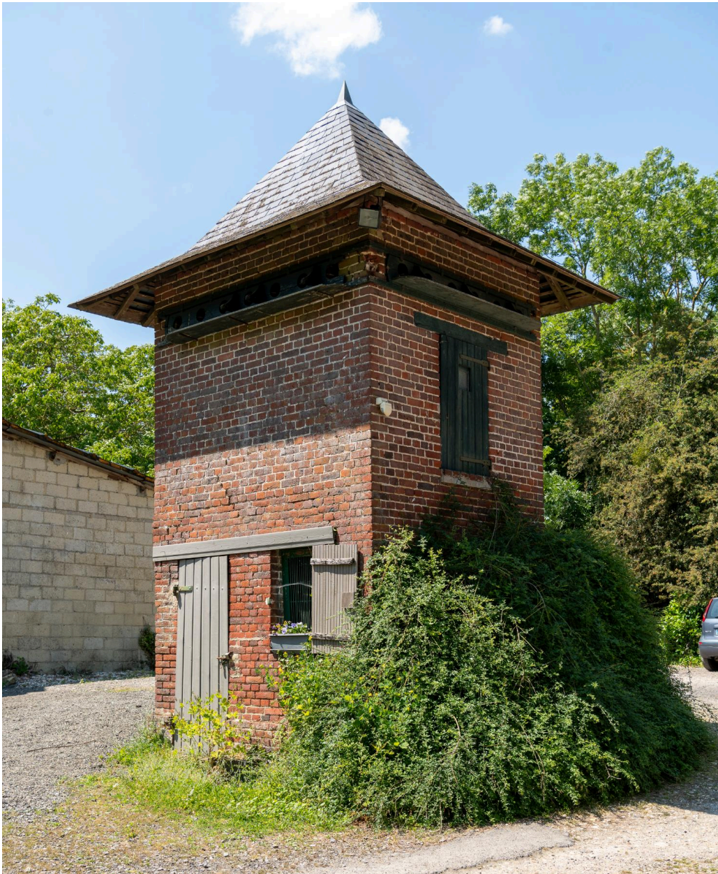
Pigeonnier, vue prise depuis le sud.
